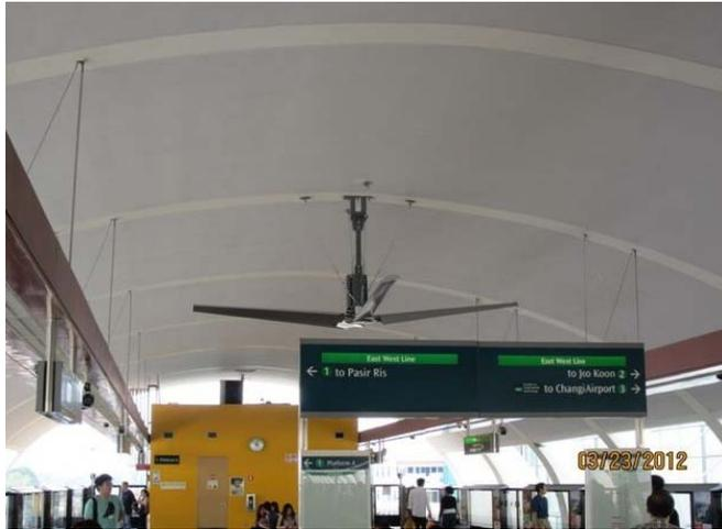
从机械连接上来说，风行大风扇结构简单，电机与转轴三向连接，增加安全性，另有一根安全钢丝绳和四根钢丝绳提供稳固支撑，保证风扇安全、平稳运行。在电气安全性上，风行风扇控制简单，每个风扇控制器包含一个工厂预制的变频马达，能够实现风扇的平稳启动和无级调速，控制盒的内部元件均具备安全触摸性能，另外，风行风扇没有类似传统地面风扇或墙面风扇的低压外接插头，避免了安全隐患，提高了电气安全性。此外，瑞泰风行大风扇通过了美国防火协会标准（NFPA）的测试，满足消防安全的要求。
